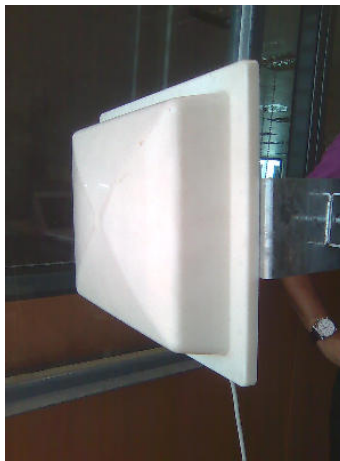
Detalle estación base y herrajes
