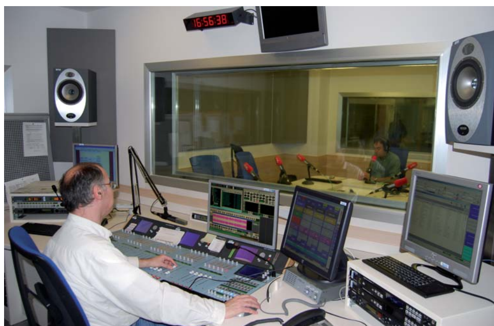
El estudio principal cuenta con dos locutorios (informativos y programas), cuatro estudios control-locutorio, tres estudios para autocontrol y cuatro cabinas para grabaciones. Estas cabinas cuentan, además, de una "mini" consola AEQ Arena con el Eagle Realtime Control para la grabación de llamadas telefónicas
