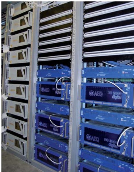
Detalle de la sala de máquinas de Radio Euskadi, donde destaca la matriz BC2000 Digital de 1024x1024, suministrada por AEQ
